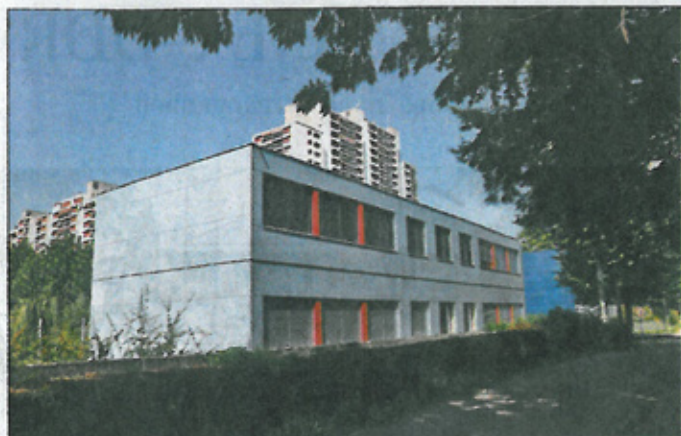
In nur fünf Wochen wurde das kleine, vollwertige Schulhaus errichtet. Fotos: zVg
