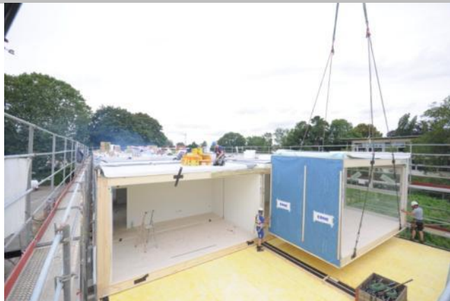
Punktgenaues Absetzen der Raummodule
