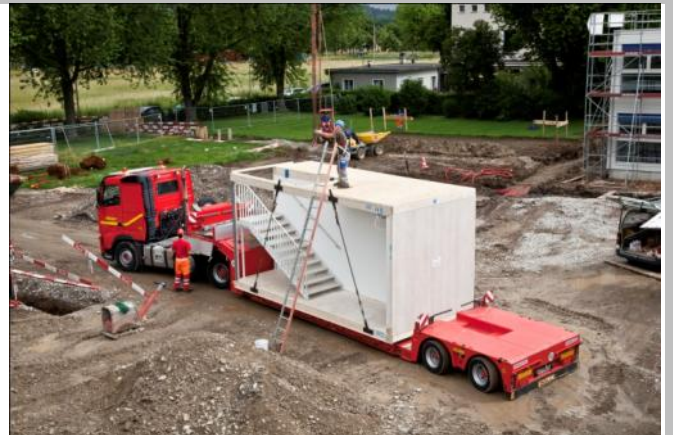
Taktgenaue Lieferung auf die Baustelle
