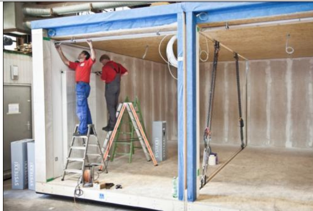
Der komplette Innenausbau erfolgt im Werk
