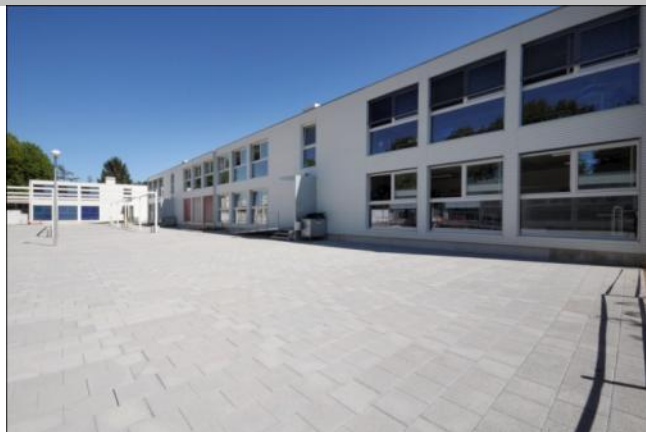
Hirzbrunnen-Schule Basel: Sicht auf Gebäude drei, zwei und eins (v.l.n.r)
