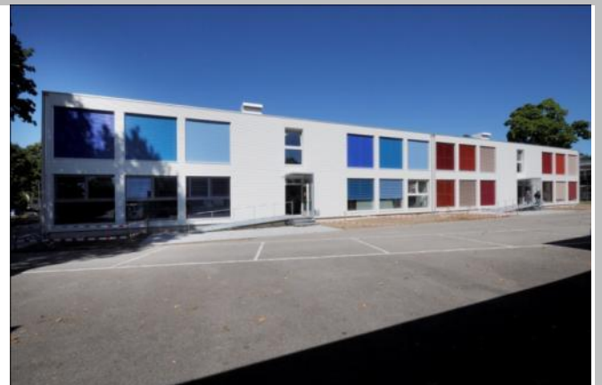
Hebel-Schule Basel: Sicht auf Gebäude drei und zwei (v.l.n.r)
