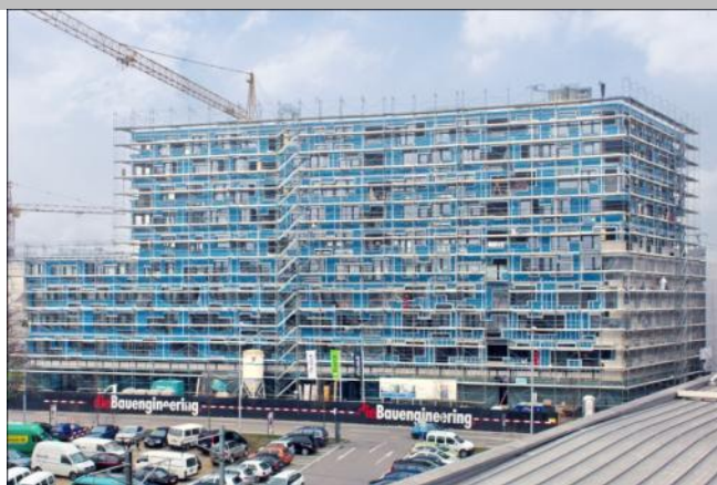
Baustelle SüdPark Basel
