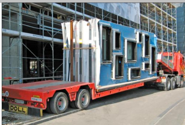
Fertiges Eckelement Fassade SüdPark
