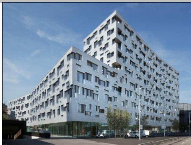
SüdPark Basel mit Fassadensystem ERNE
