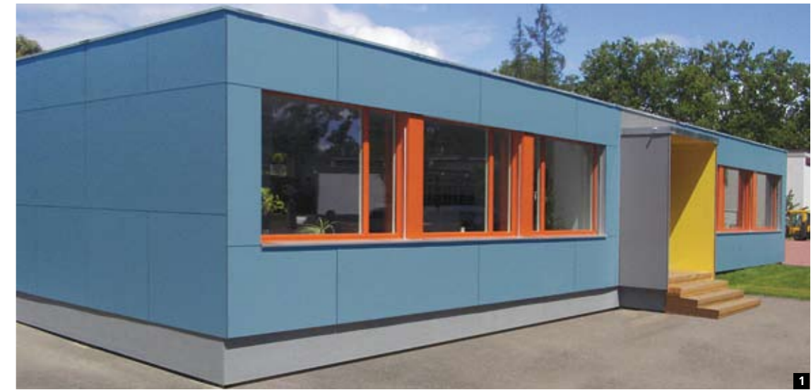
1 Standard-Grundriss Schulhaus mit zwei Klassenzimmern und einem Eingangsmodul. Module Blau = Raummodul Gelb = Eingangsmodul Grau = Sanitär- und Technikmodul
