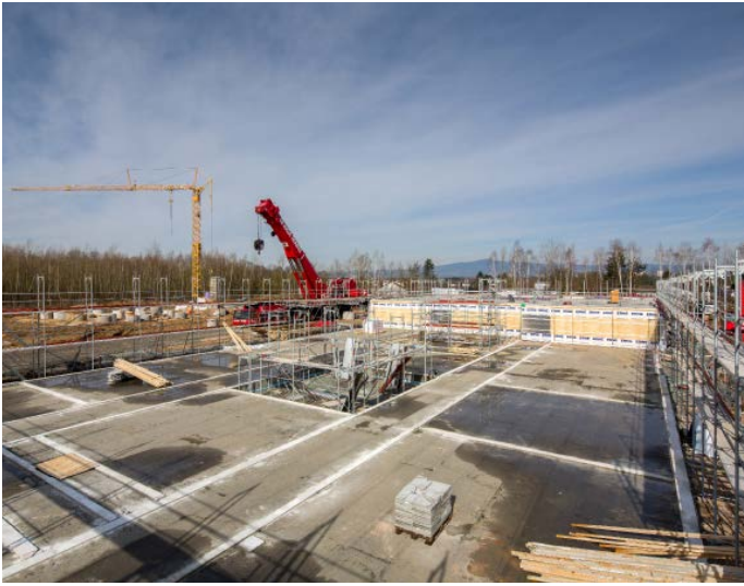
▲ Großbaustelle Schulneubau in Holz-Modulbauweise
