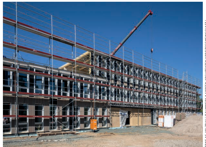
▲ Das Schulgebäude des Campus entsteht
