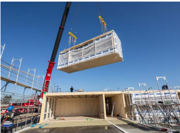
▲ Aus einzelnen Holzbaumodulen entstehen Klassenräume
