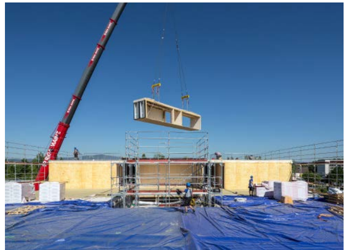
▲ Modul um Modul wird das Gymnasium errichtet
