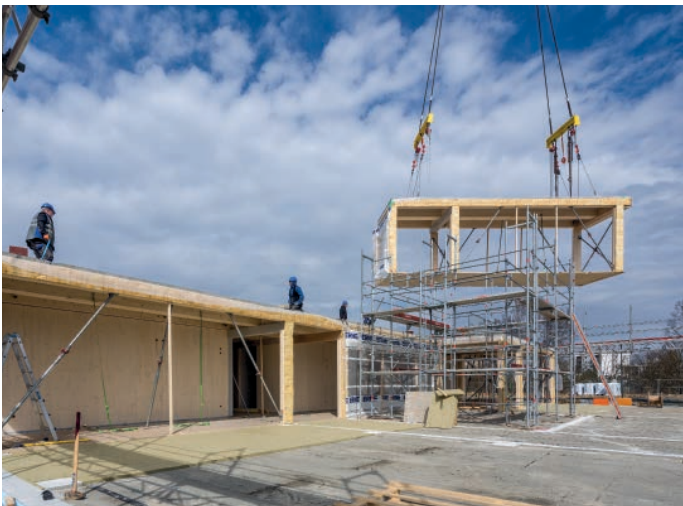
▲ Ein Kran lädt die Module ab und bringt sie in die richtige Position
