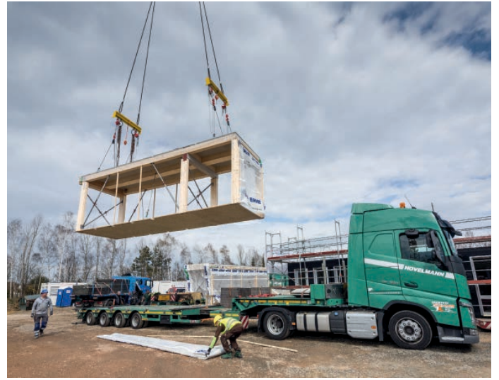
▲ Per Lkw werden die vorgefertigten Module angeliefert
