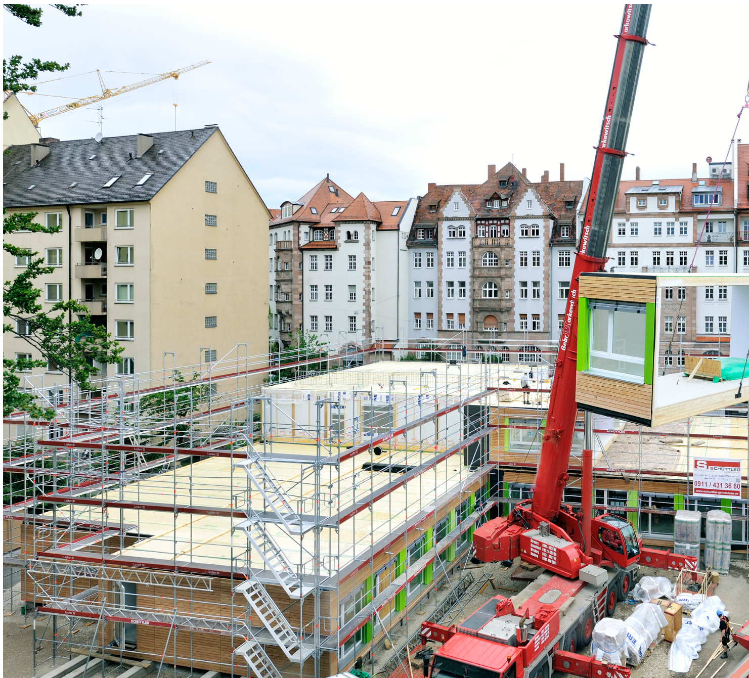
Blick zurück: In nur acht Monaten entstand der dreigeschossige Holz-Modulbau in Nürnberg.
