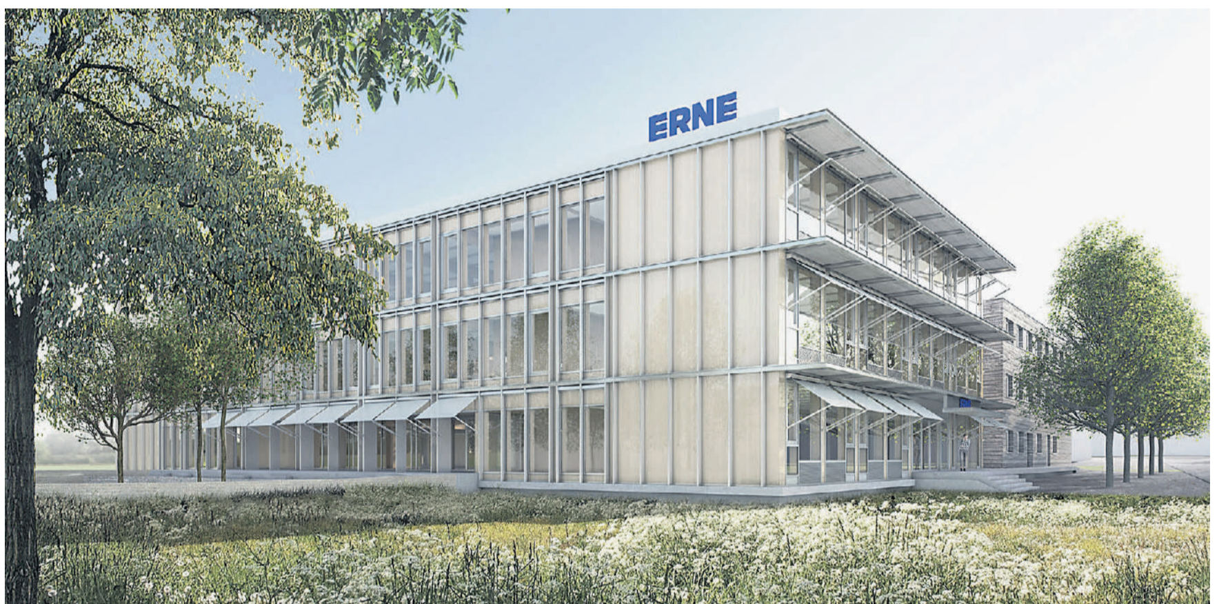
Der Neubau der Erne AG Holzbau in Stein soll bereits in einem Jahr bezugsbereit sein.
