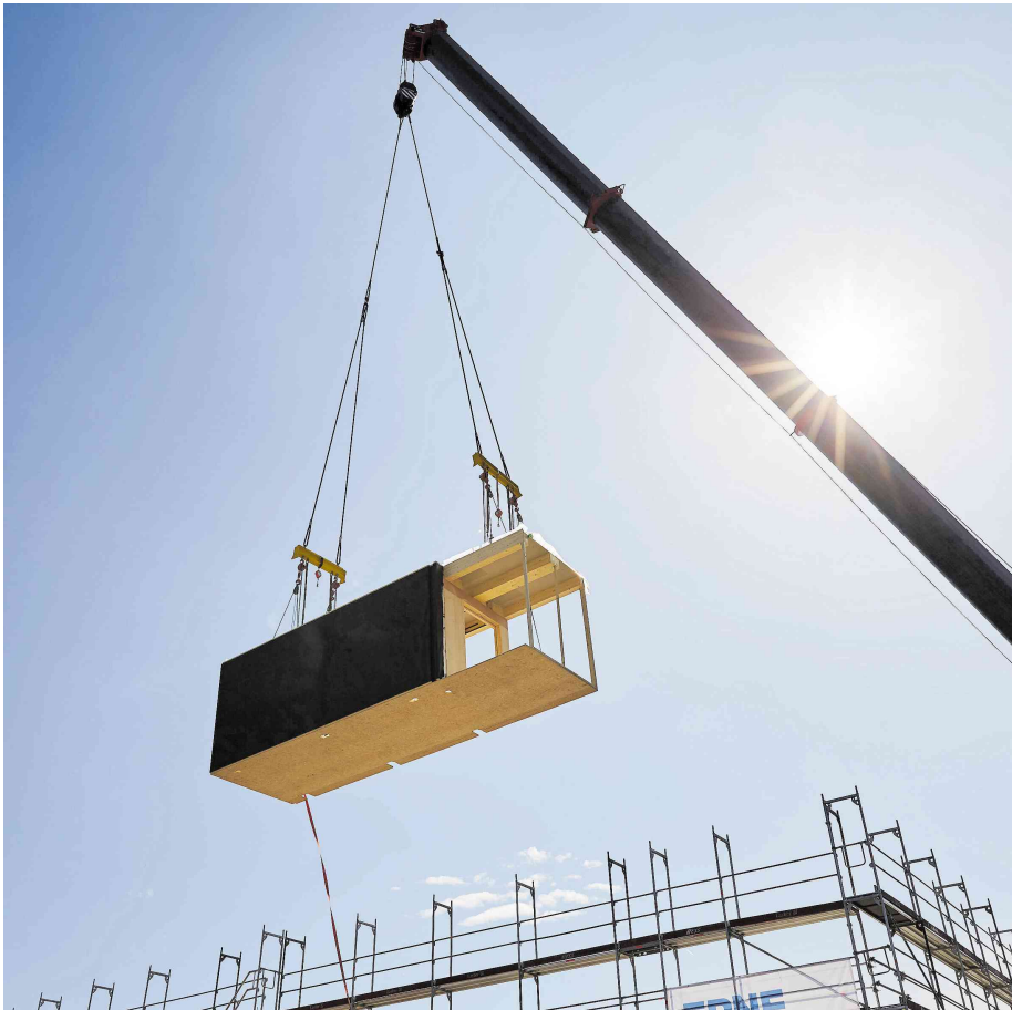
Der Weg der Bauklötze: In der Fabrik in der Nähe von Basel werden die Holzelemente gefertigt, seit neuestem auch unter Verwendung von Beton (rechts oben). Selbst Fenster und Steckdosen sind schon eingebaut, wenn die Module auf dem Tieflader in Frankfurt ankommen (rechts unten). Dort werden sie mit dem Kran an ihren Bestimmungsort gehievt und miteinander verbunden. Aus drei Elementen entsteht so zum Beispiel ein Klassenraum mit angrenzendem Gang.
