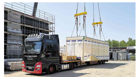
Der Weg der Bauklötze: In der Fabrik in der Nähe von Basel werden die Holzelemente gefertigt, seit neuestem auch unter Verwendung von Beton (rechts oben). Selbst Fenster und Steckdosen sind schon eingebaut, wenn die Module auf dem Tieflader in Frankfurt ankommen (rechts unten). Dort werden sie mit dem Kran an ihren Bestimmungsort gehievt und miteinander verbunden. Aus drei Elementen entsteht so zum Beispiel ein Klassenraum mit angrenzendem Gang.
